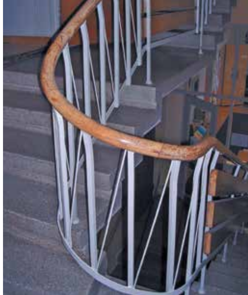
Portaikön lankametalликаiteen yksityiskohta.
