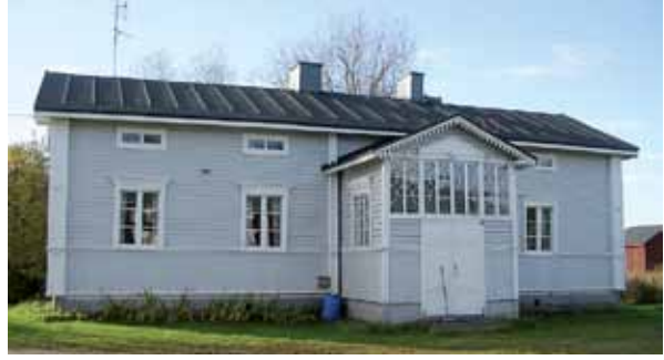
Kuva 146. Lisakan pienempi asuinrakennus. LKYT 2007.
