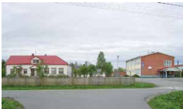
Kuva 234. Arpelan koulurakennuskokonaisuus. LKYT 2006.
