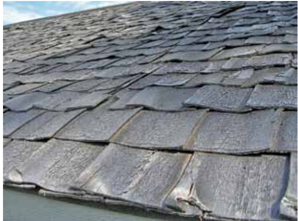
Kuva 197. Kala-aitan kattoa. LKYT 2007.
