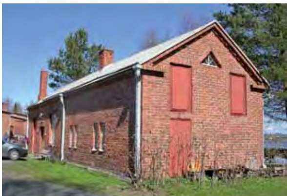
Kuva 84. Entinen vesilaitos. LKYT 2007.
