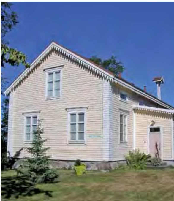
Kuva 95. ”Hannan talo” on rakennettu 1800-luvun puolivälissä. LKYT 2006.
