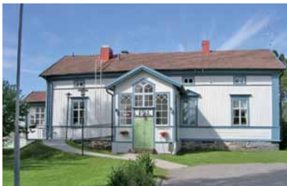
Kuva 113. Pappilarakennus on rakennettu vuonna 1842. LKYT 2006.
