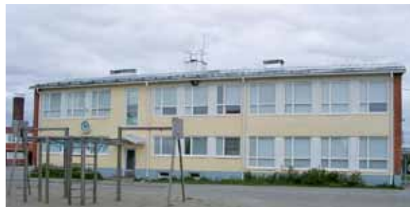
Kuva 233. Vuonna 1959 rakennettu koulurakennus. LKYT 2006.
