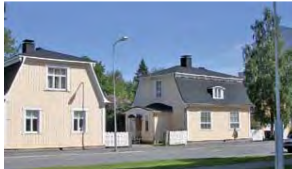
Kuva 71. Kahvimyllytalot Saarenpään kadun näkymässä. LKYT 2006.
