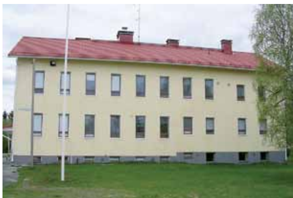
Kuva 226. Näätsaaren jälleenrakennusajalla rakennettu koulu. LKYT 2006.
