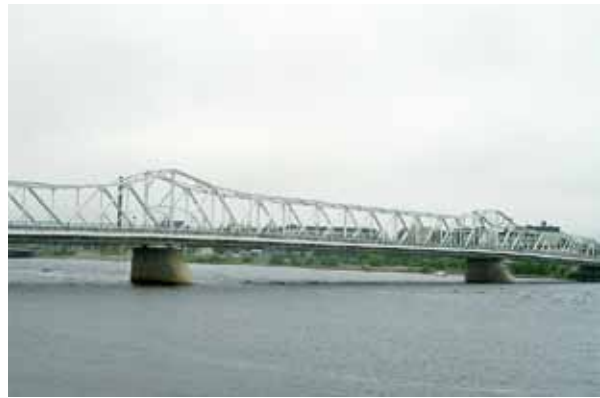
Kuva 238. Hannulan silta. LKYT 2006.
