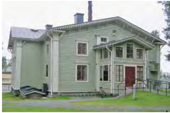
Kuva 67. Säipän talon etujulkisivu. LKYT 2006.
