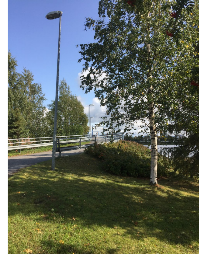
Silta alkaa penkereeltä
