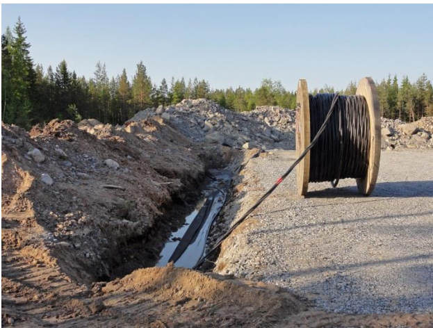
Kuvapari 2.18. Maakaapelit upotetaan huoltoteiden yhteyteen (kuvat: Ville Suorsa/FCG).
