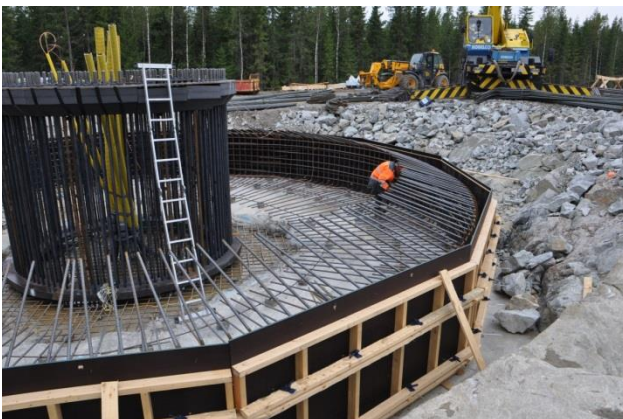
Kuvapari 2.19. Tuulivoimalan perustusten rakentamista. (Kuvat: Leila Väyrynen, FCG)
