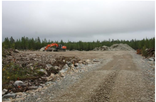
Kuvapari 2.17. Tuulivoimapuiston rakentaminen alkaa huoltoteiden ja pystytysalueiden rakentamisella (kuvat: Ville Suorsa, FCG).
