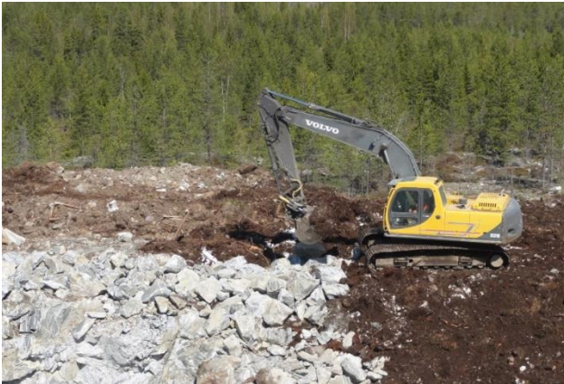
Kuvapari 2.17. Tuulivoimapuiston rakentaminen alkaa huoltoteiden ja pystytysalueiden rakentamisella (kuvat: Ville Suorsa, FCG).
