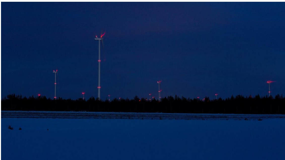
Bild 2.1. Fast röd flyghinderbelysning. (Bild: Ville Suorsa, FCG)
