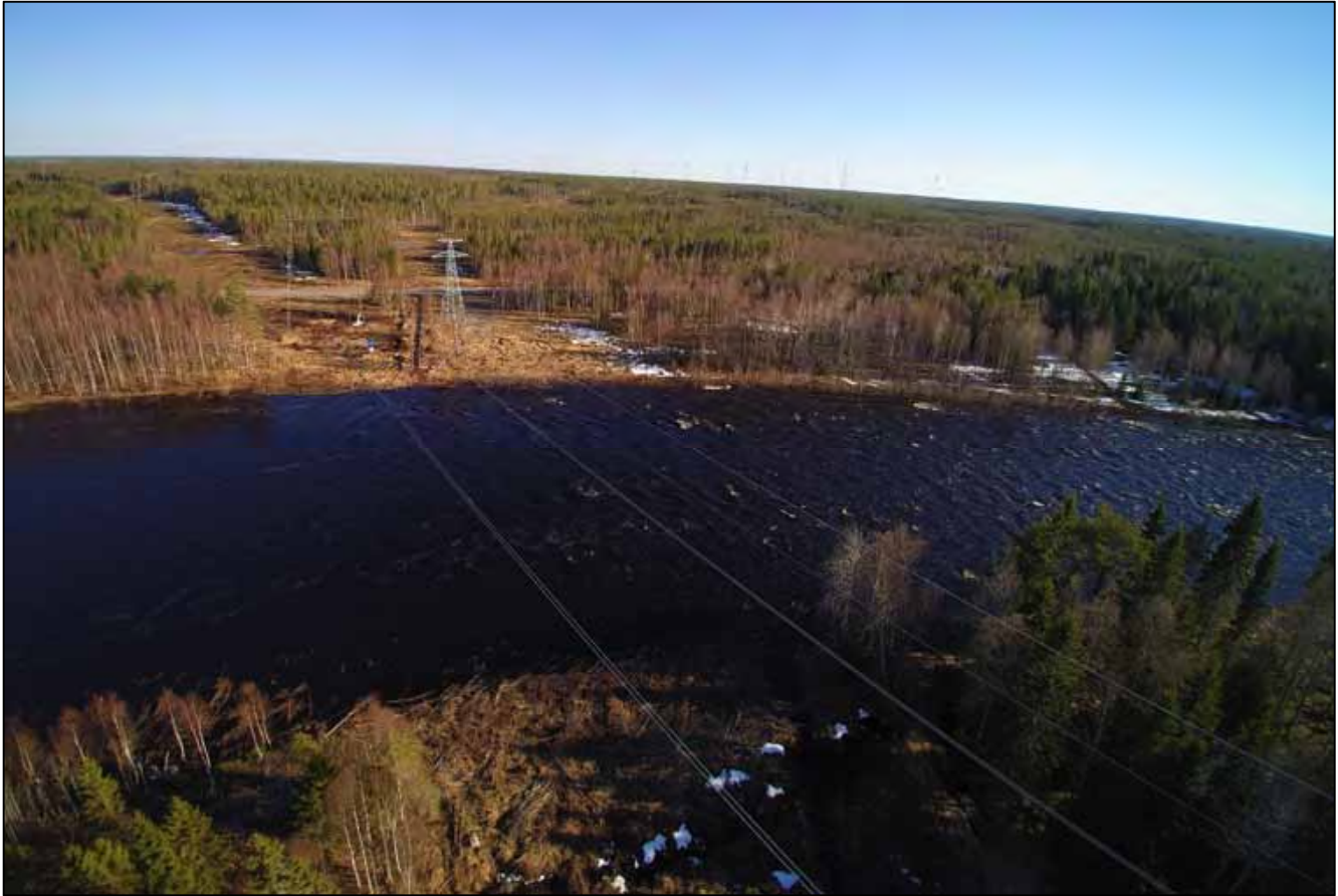
Kuva 81. Näkymä Simojoen ylityskohdasta itään päin. Uusi voimajohto sijoittuu kuvassa näkyvän nykyisen harustetun voimajohton vasemmalle (pohjois-) puolelle.
