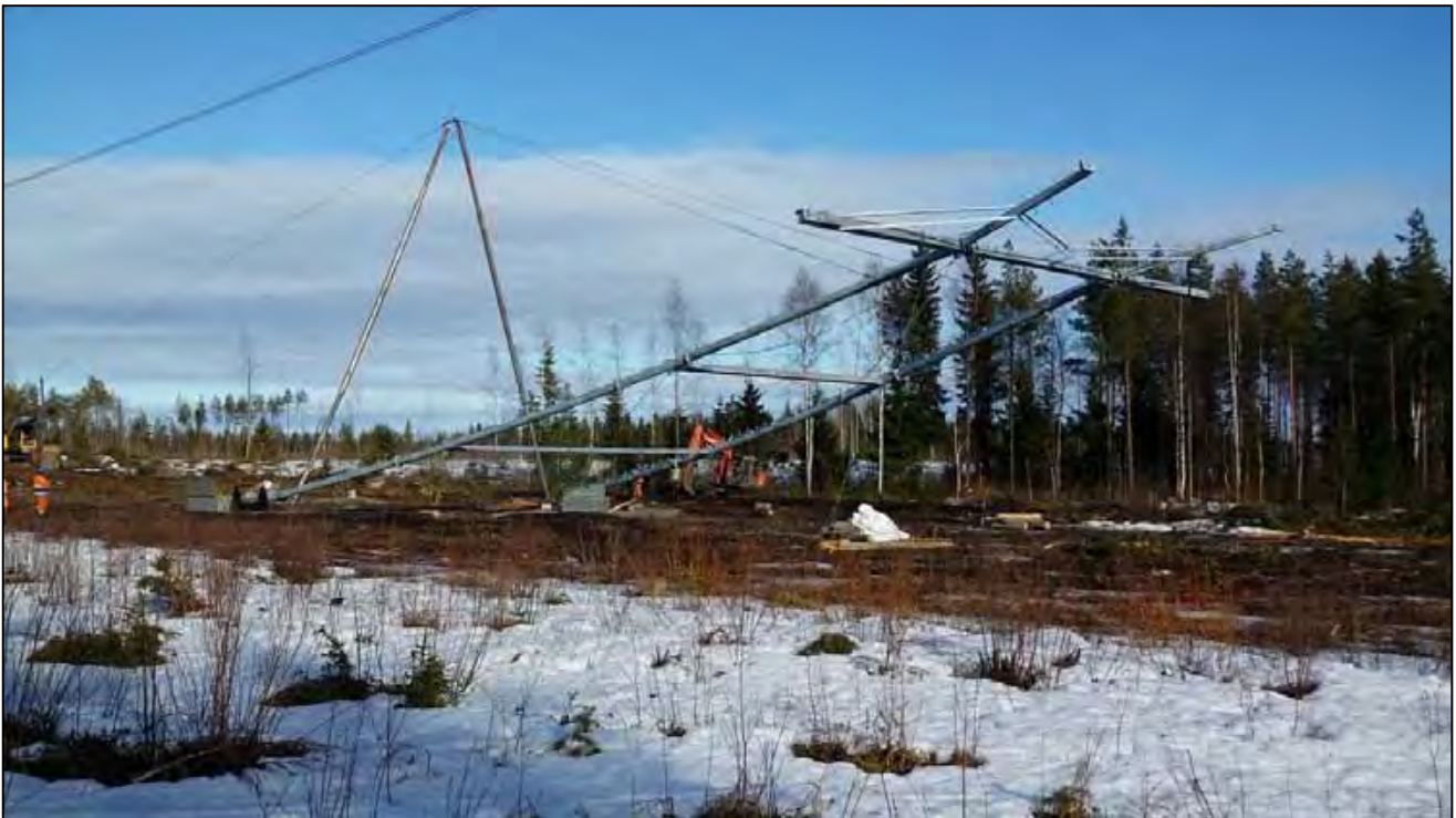
Kuva 9. Voimajohtopylvään pystytys.
