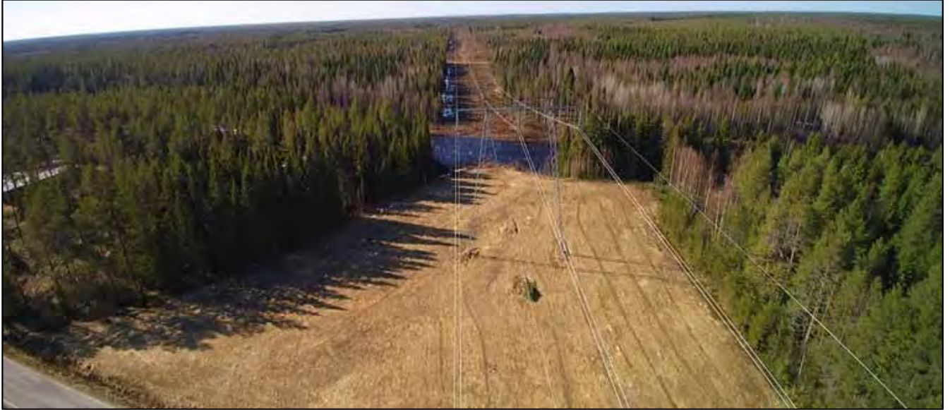
Kuva 79. Näkymä Kuivajoen ylityskohdasta, jossa jokirannat ovat peitteisiä. Uusi voimajohto sijoittuu nykyisen voimajohdon oikealle puolelle. Kuva kaakosta luoteeseen.
