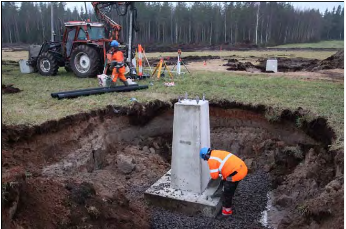
Kuva 7. Pylvään perustuselementin asentaminen.
