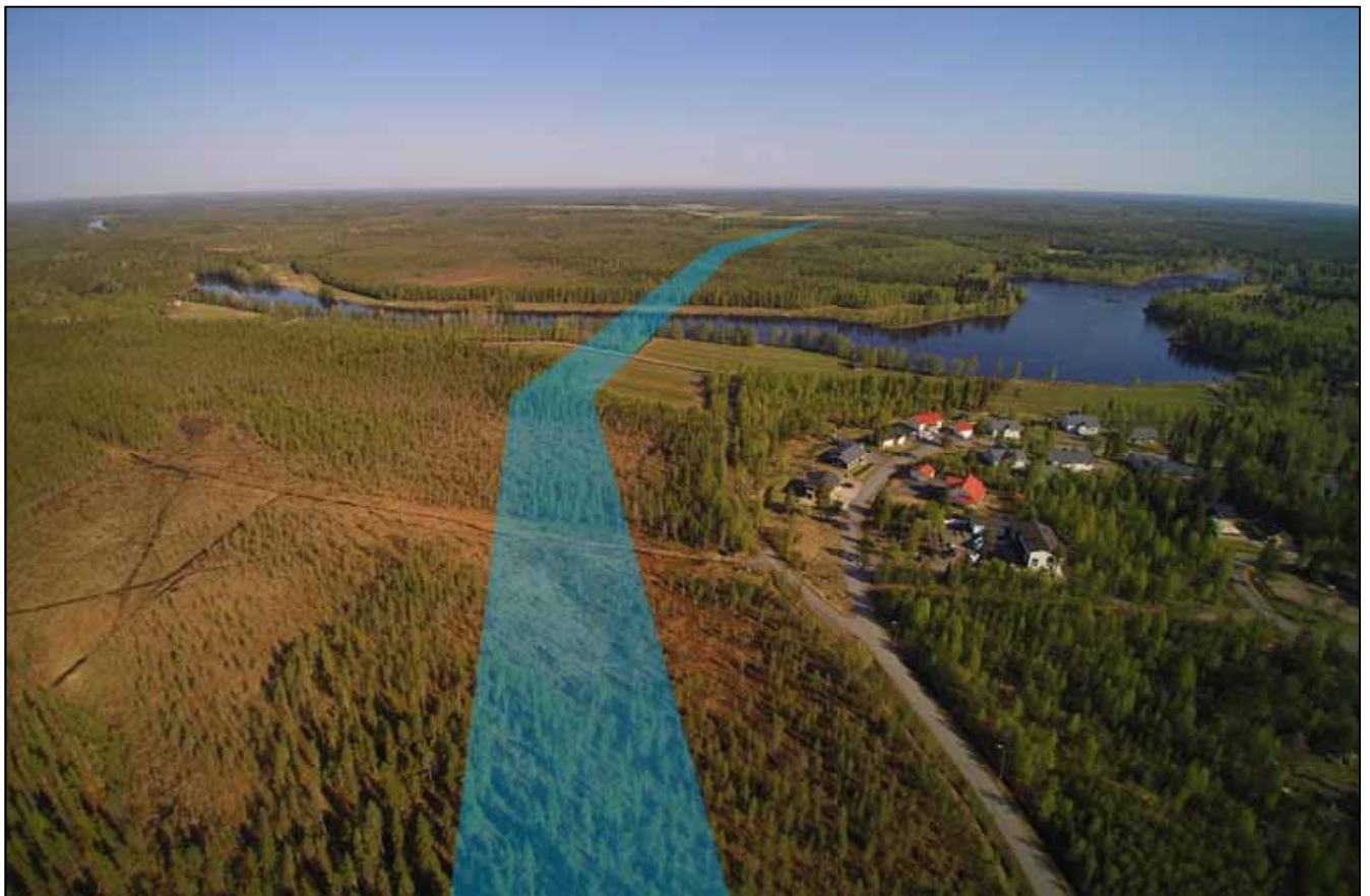
Kuva 76. Viistoilmakuva Kiiminkijoen ylityskohdasta Vesalassa. Voimajohtoalue on esitetty läpikuultavana alueena.
