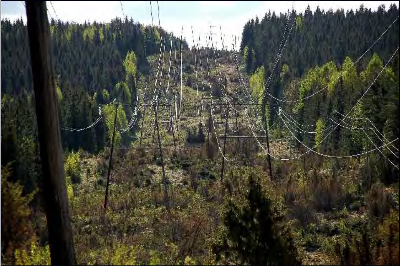
Kuva 10. Esimerkki valikoivasta raivauksesta.
