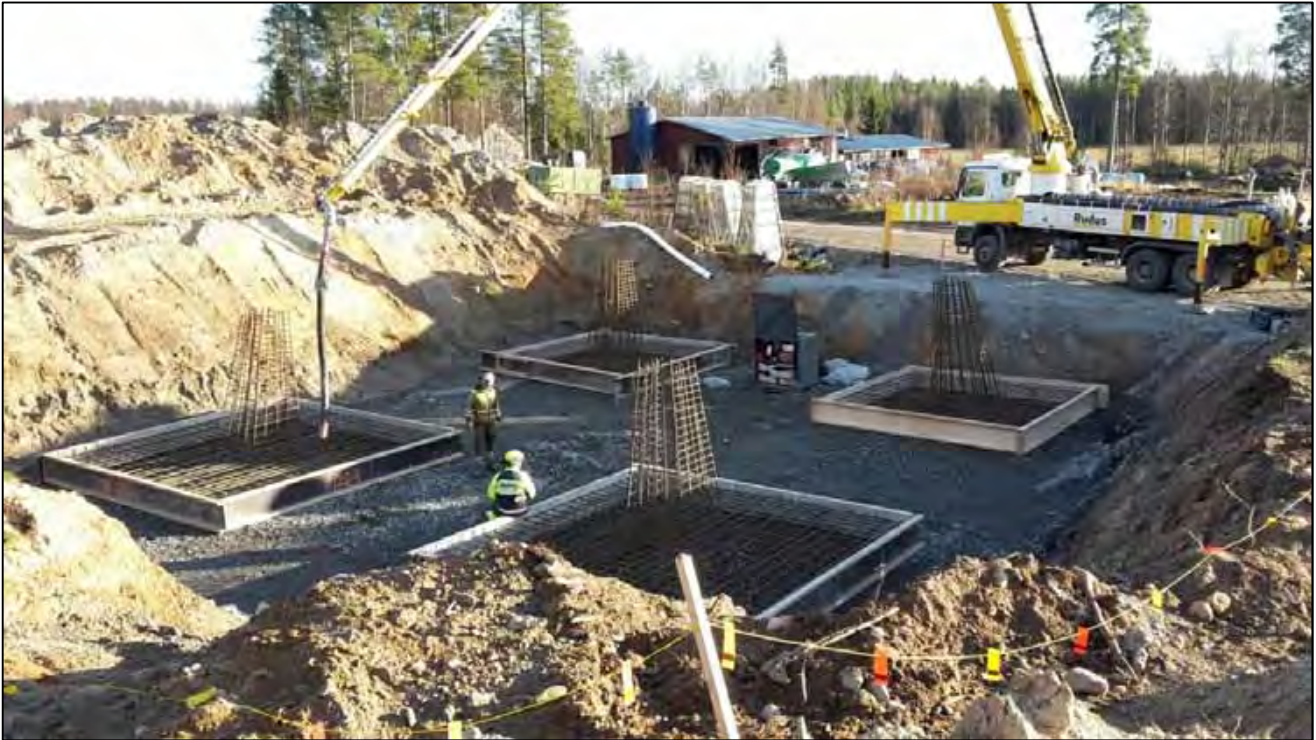
Kuva 8. Vapaasti seisovan pylvään perustuksen pohjatöitä.
