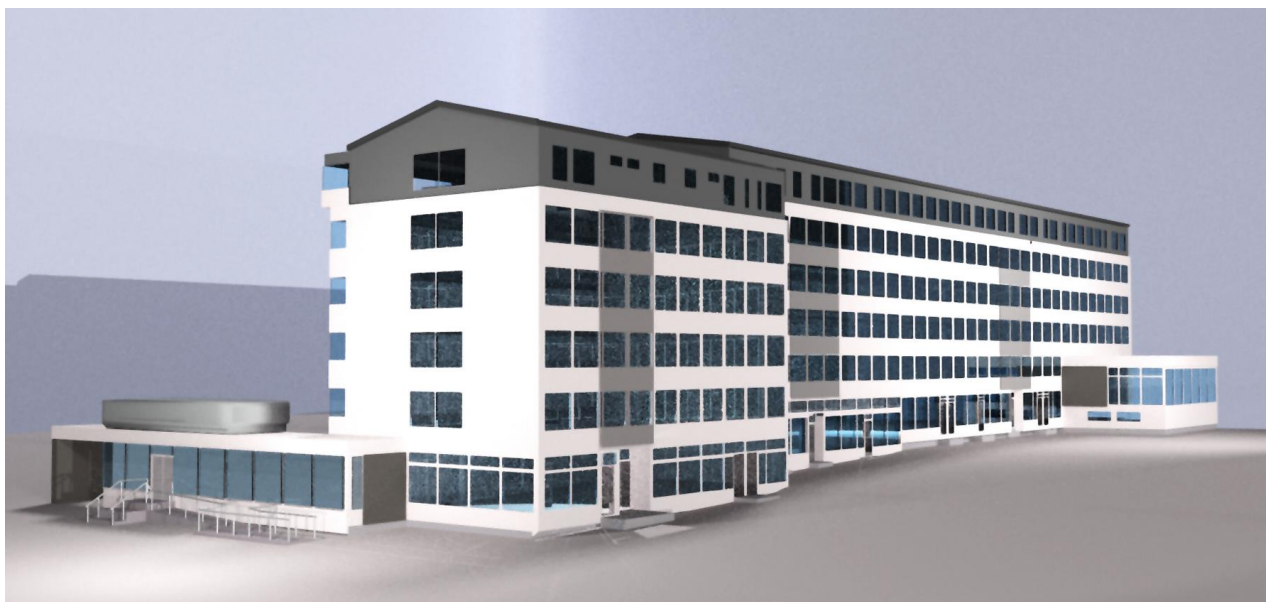
KUVA 9 Rakennus uuden kerroksen lisäämisen jälkeen Laivurinkadulta katsottuna
