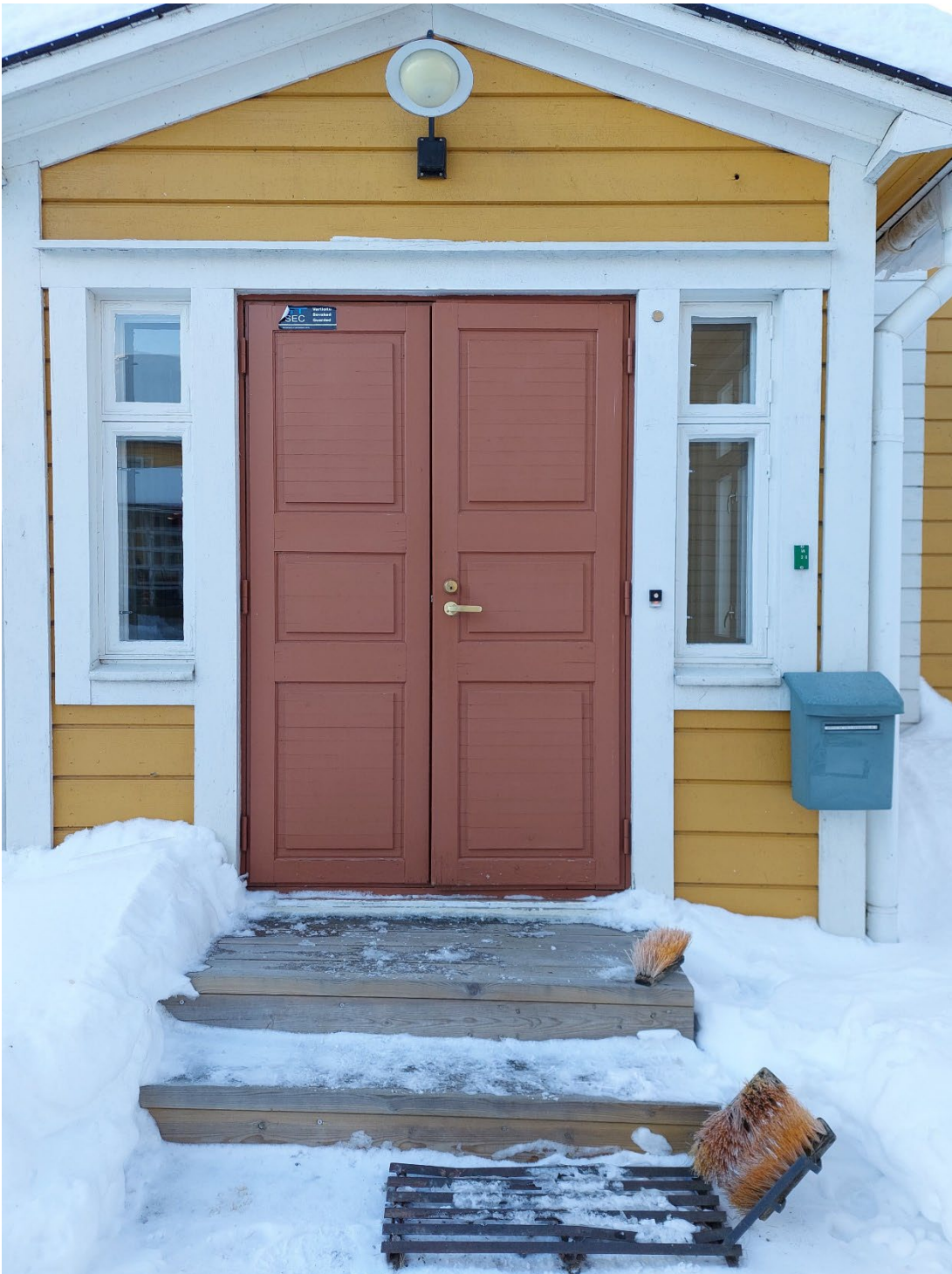
Kuva 4 Sisäänkäynti ja ulkorappuset.
