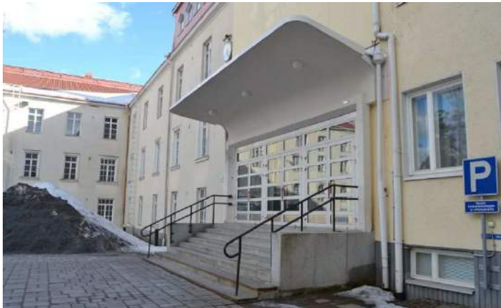
Kuva 82: Pääsisäänkäynti katoksineen, 2018 (TLMM/Teija Ylimartimo)
