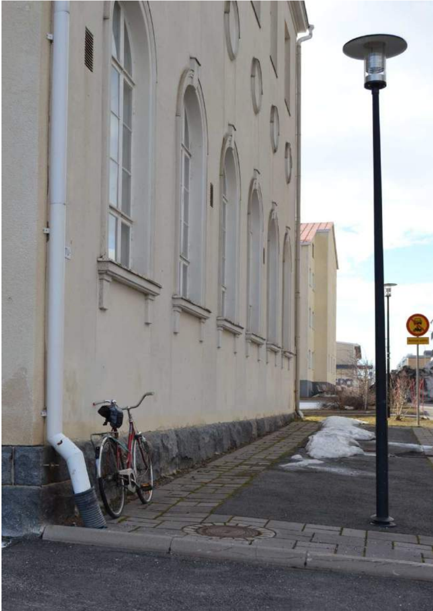
Kuva 88: Vanhan puolen voimistelusalin ikkunat, 2018 (TLMM/Teija Ylimartimo)
