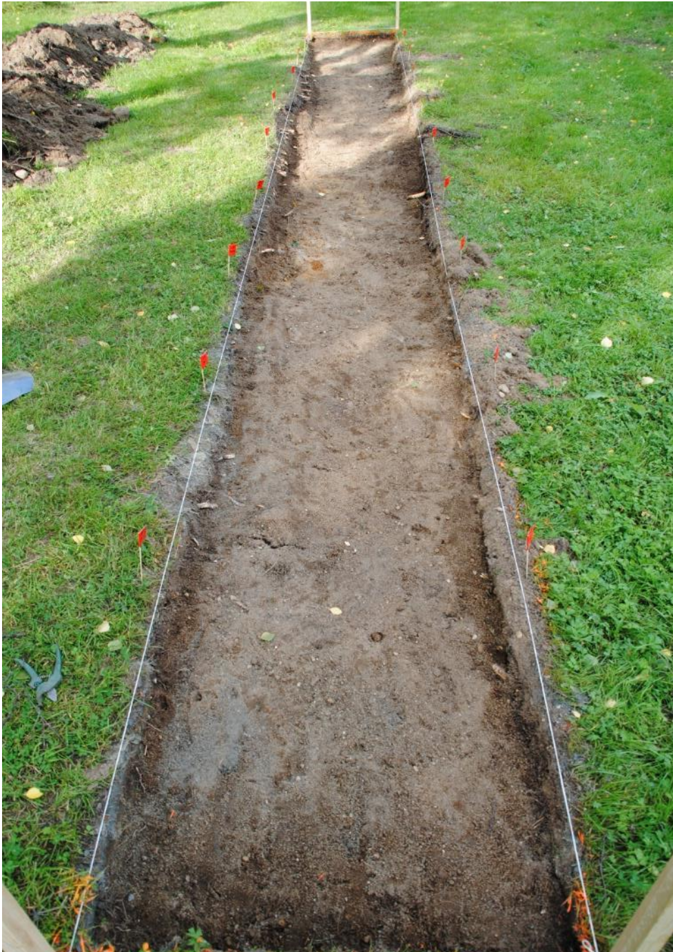
Kuva 3. Koeoja 1 idästä koneellisen kaivun ja siistimisen jälkeen.
