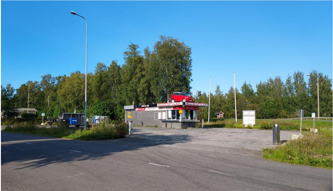
Kuva 10. Suunnittelualueella sijaitseva autogrillin rakennus (8/23).
