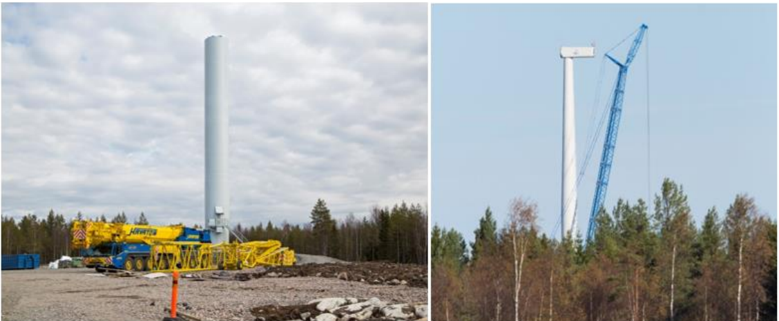
Kuva 25. Tuulivoimalan kokoamista. (Kuvat: FCG)
