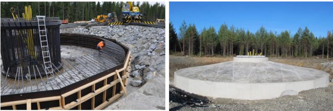
Kuva 24. Tuulivoimalan perustusten rakentamista. (Kuvat: FCG)
