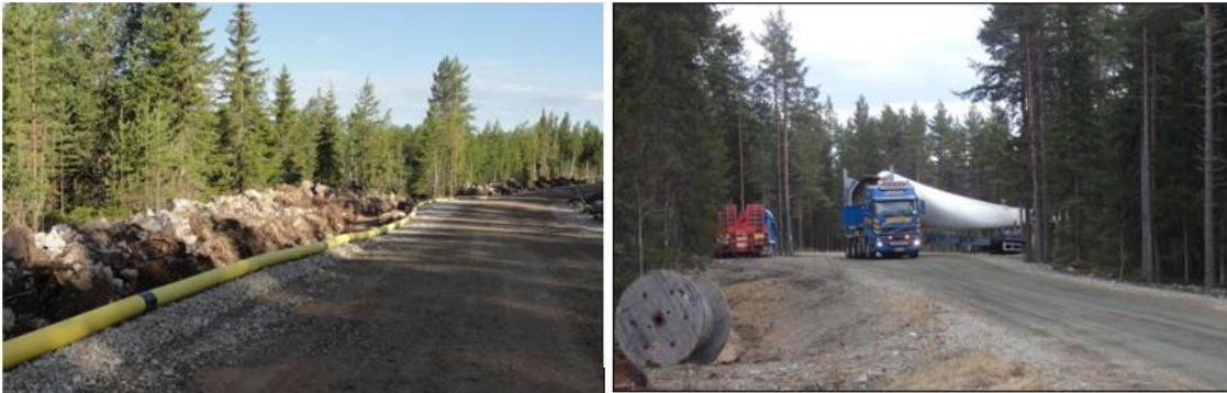
Kuva 17. (Vasemmalla) Esimerkki tuulivoimapuiston rakennus- ja huoltotiestä. Teitä käytetään muun muassa betonin, soran ja voimaloiden komponenttien kuljetuksiin sekä tuulivoimapuiston käyttövaiheessa huoltoajoihin. Maakaapeli sijoitetaan ojakaivantoon tien reuna-alueelle. (Oikealla) Tuulivoimalan osia kuljetetaan erikoiskuljetuksina. (Kuvat: FCG).
