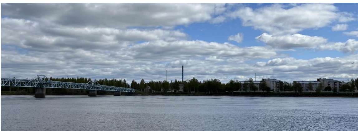
Kuva 4. Suunnittelualue sijoittuu kuvassa kevyenliikenteen sillan oikealle puolelle (7/23).
