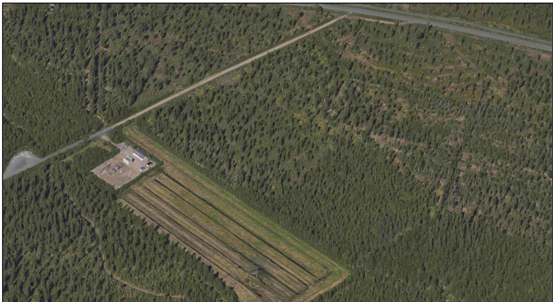
Kuva 1. Suunnittelualueen keskiosa kesällä 2022. Suunnittelualue on pääosin metsäaluetta. Suolle ojjetun peltoaukean pohjoispuolella sijaitsee sähköasema.
