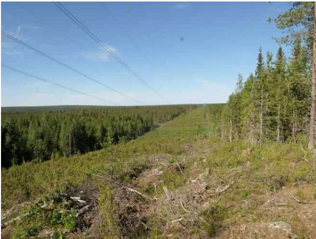
Kuva 15. Voimalinja hankealueen keskiosassa, länteen.
