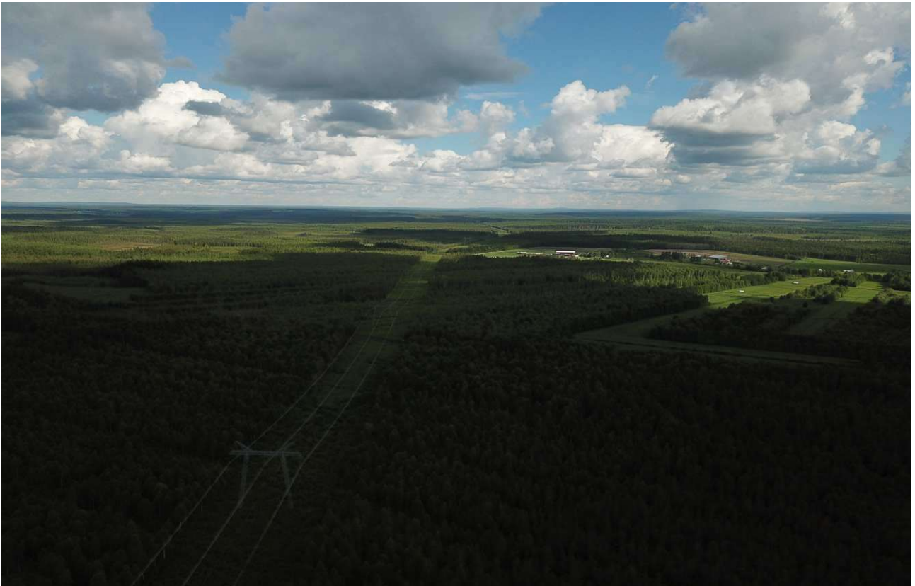
Kuva 48. Linjakäytävä Viitakoskelta pohjoiseen. Dronekuva, korkeus 115 m.
