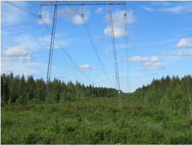
Kuva 58. Linjaus Santalammen eteläpuolella.
