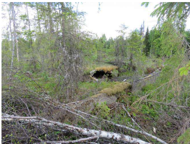
Kohde 5-1 talon betoniperustus
