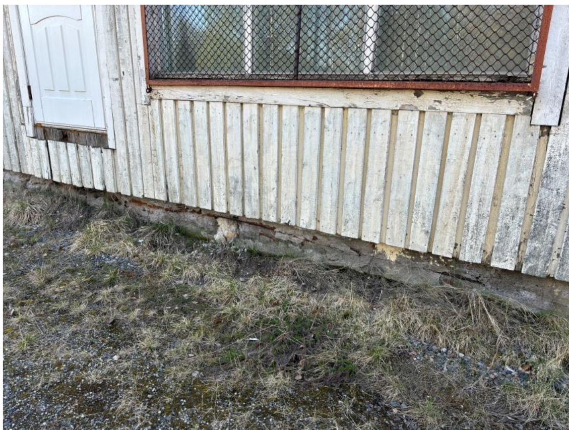
Kuva 18. Ote kuntoarvion s.6 valokuvadokumentaatiosta, jonka kuvatekstissä arvion laatija toteaa "Ikkunoiden kunto heikko, pellitykset puuttuvat. Rännit ja syöksytorvet puuttuvat. Perustus on pettänyt.". Kuva J. Vanhapiha 2024.
