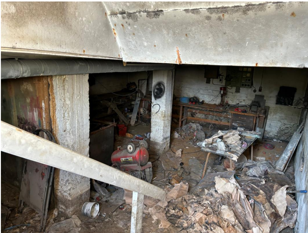
Tulva noussut kellariin ja jäljistä päätellen kellariin on johtunut vesivuotoja.
