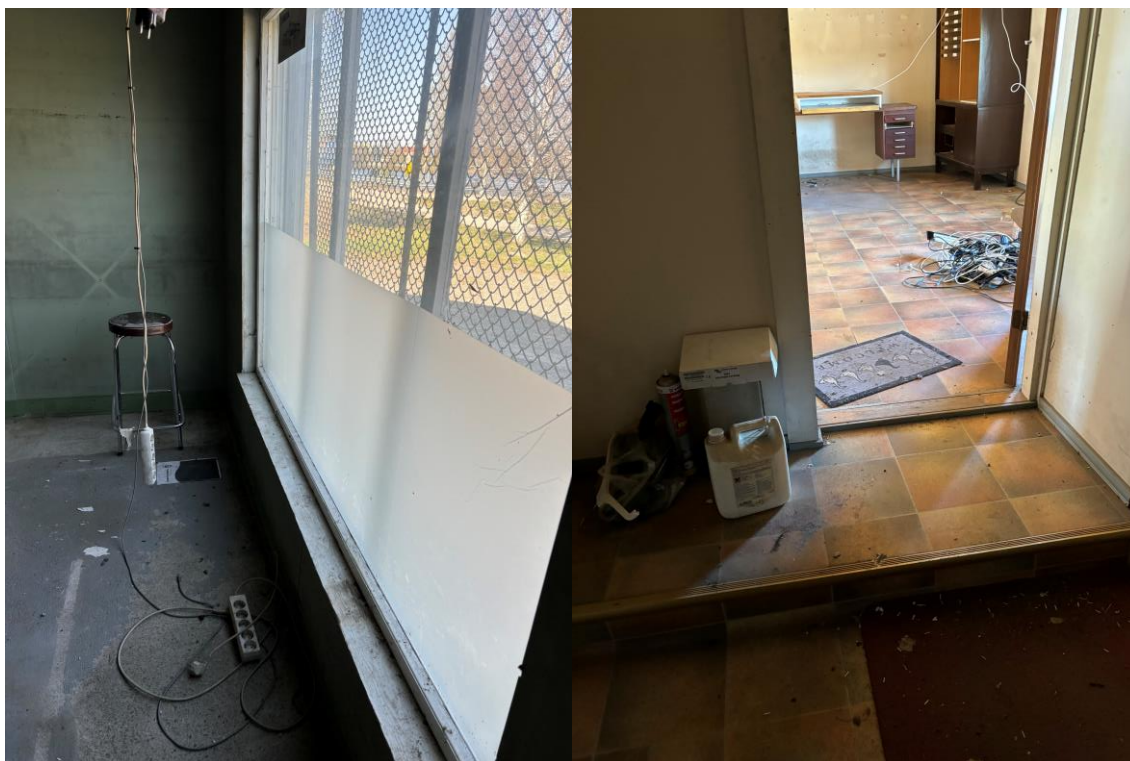
Ikkunat vaihdettava. Lattiatasot eri tiloissa eritasoilla, lukuisia kynnyksiä.
