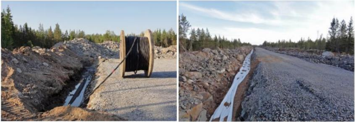
Bild 20. Markkablar grävs ner intill servicevägar (Bilder: FCG).
