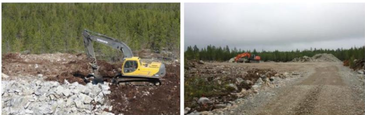
Bild 19. Byggandet av en vindkraftspark inleds från servicevägarna och uppförandeområdena
